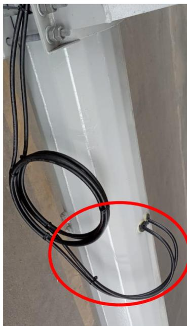
Os cabos que saem tanto da antena de MW como do GPS tem por obrigação fazer um formato de pingadeira evitando assim infiltrações no Poste.
